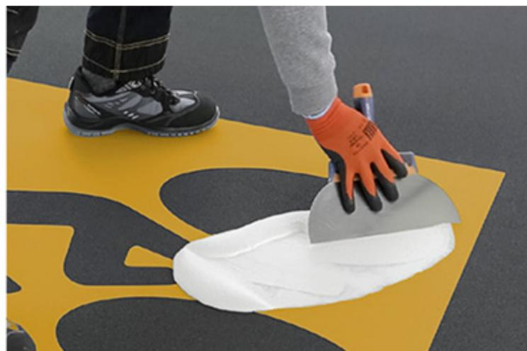
2 Lissage manuel d'une résine à froid
