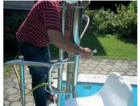
Serrer le support du siège (la hauteur du siège est réglable)
