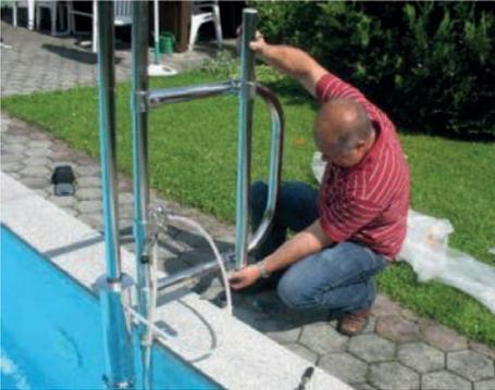
Mise en place du pilier supplémentaire et vissage au panneau à l'aide de l'écrou-raccord
