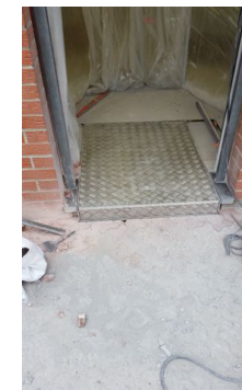
Pose, mise à niveau Fixation du cadre
