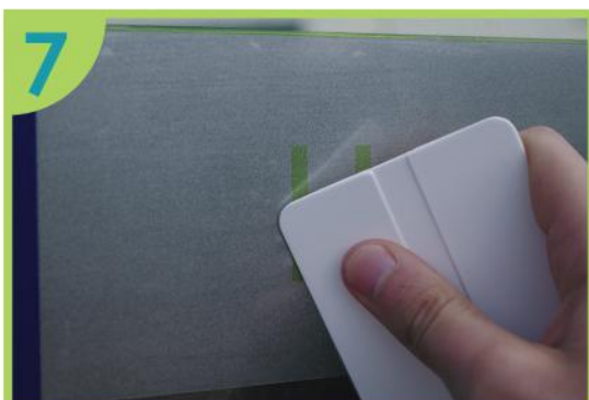
7. Chasser les bulles d'air grâce au racloir
