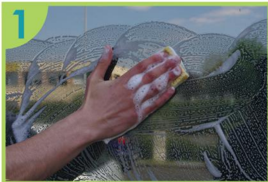
1. Nettoyer et dégraisser la surface de pose
