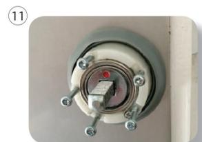
11 Face au chant de la porte, le MECA S avec un point rouge vers le haut s'installe à gauche et le MECA S avec le point vert positionné en haut s'installe à droite.
