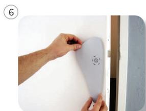
6 Coller la plaque de propreté sur la porte en utilisant le carré en guise de gabarit de pose.
